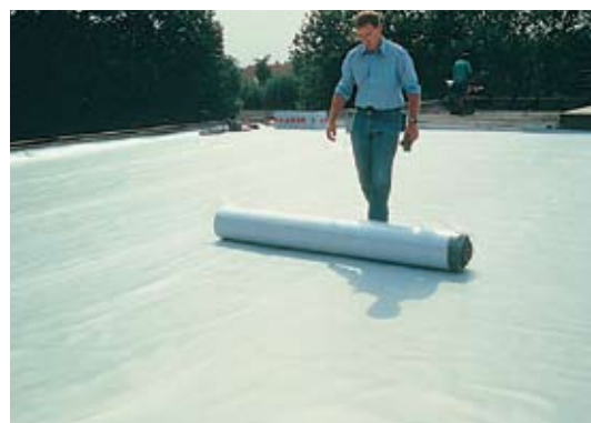
Fig. 2: Pression sur la membrane posée
