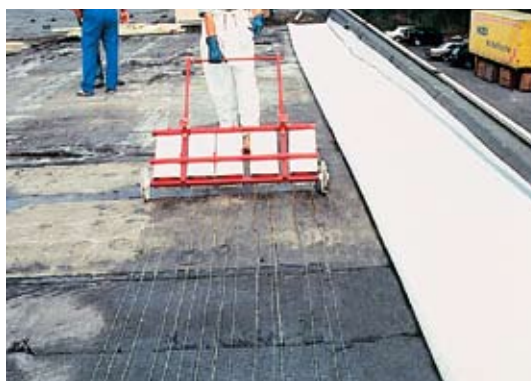
Fig. 1: Application de colle avec un chariot
